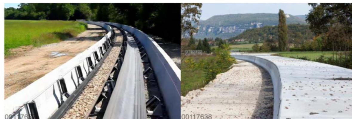
Illustration du convoyeur semi-enterré (Source : résumé non technique de l'étude d'impact de CIGEO)
